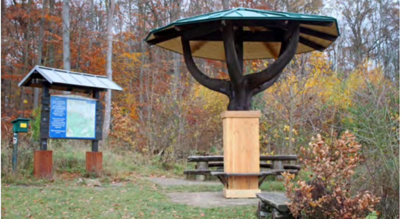
Die Ansicht des Rastplatzes „Schirm“ nach Abschluss der Erneuerungsarbeiten im Oktober 2023.
